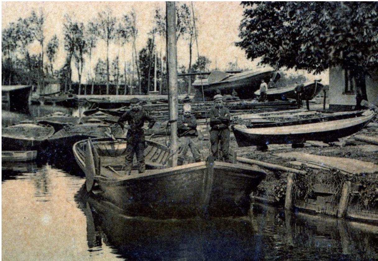
Joure, scheepswerf Auke van der Zee. Een ijzeren Friese praam als kopie van een houten Friese praam. Met veel minder ronding dan de ijzeren pramen die na 1900 populair werden.
