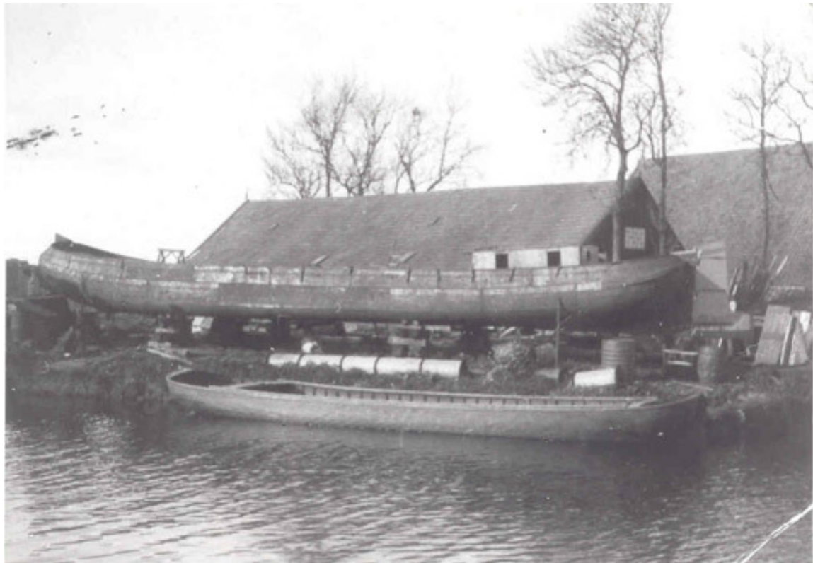
Drachten, scheepswerf bij het Buitenstvallaat. De scheepsbouwer Jan Oebeles van der Werff bouwt een skûtsje. Voor de kant zijn ijzeren praam waarmee hij zijn materiaal ophaalde.
